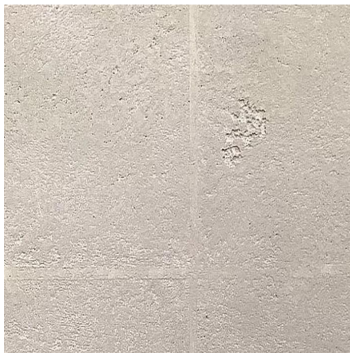
Рисунок 1.7 - Штукатурка Siltek PM-114 та результат нанесення
