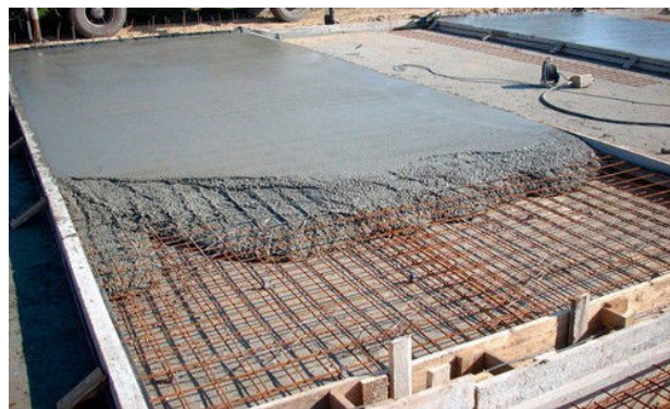
Рис. 24 Схема утеплення перекриття..... Рис. 25 Зразок заливки перекриття
