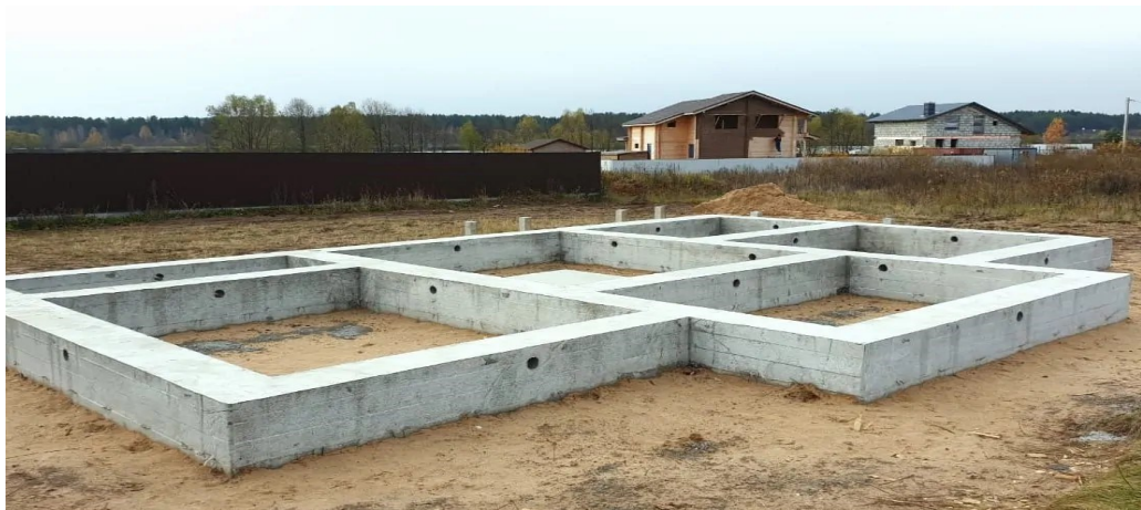
Рис. 22 Фото готового монолітного стрічкового фундаменту
