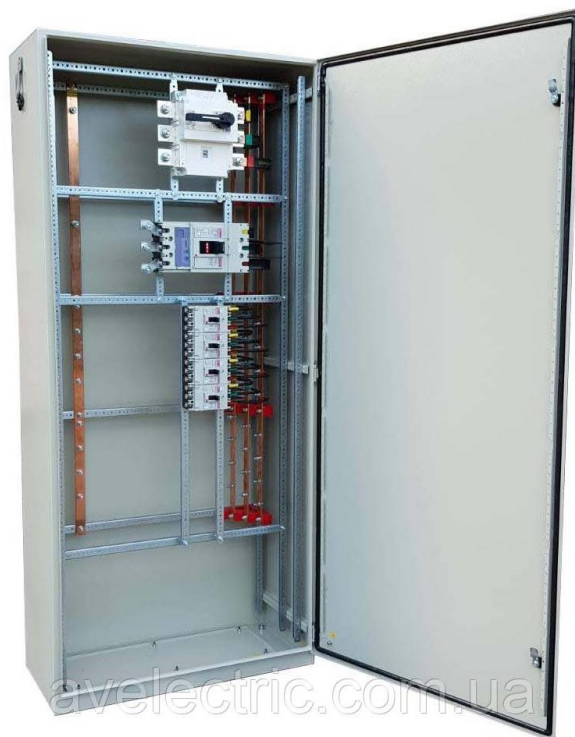
Рисунок 2.2 - Вводно-розподільчий пристрій ВРУ-76М-1 [9]
