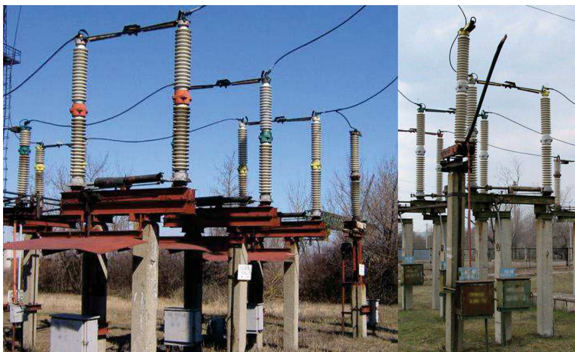
Рисунок 1.5 - а) Відмикач ВД-110/400 та б) короткозамикач КЗ-110
