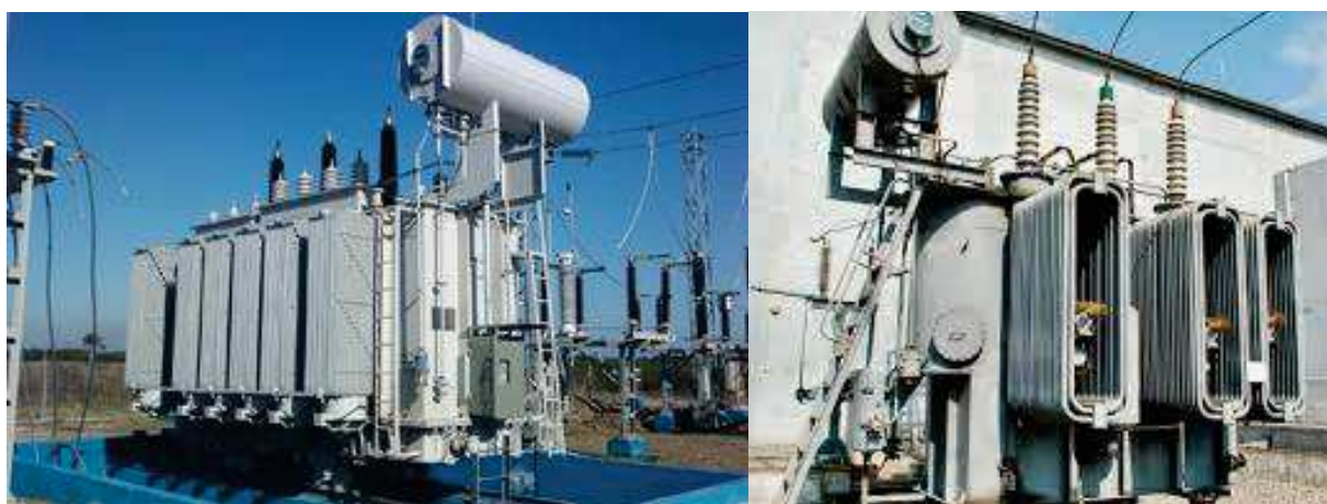
Рисунок 1.6 - Силові трансформатори а) ТМН-6300/110 та б) ТМТН-6300/110
