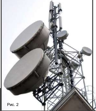
Рис. 1 –Конструктивного виконання приймального блоку цифрової апаратури MINI-LINK
