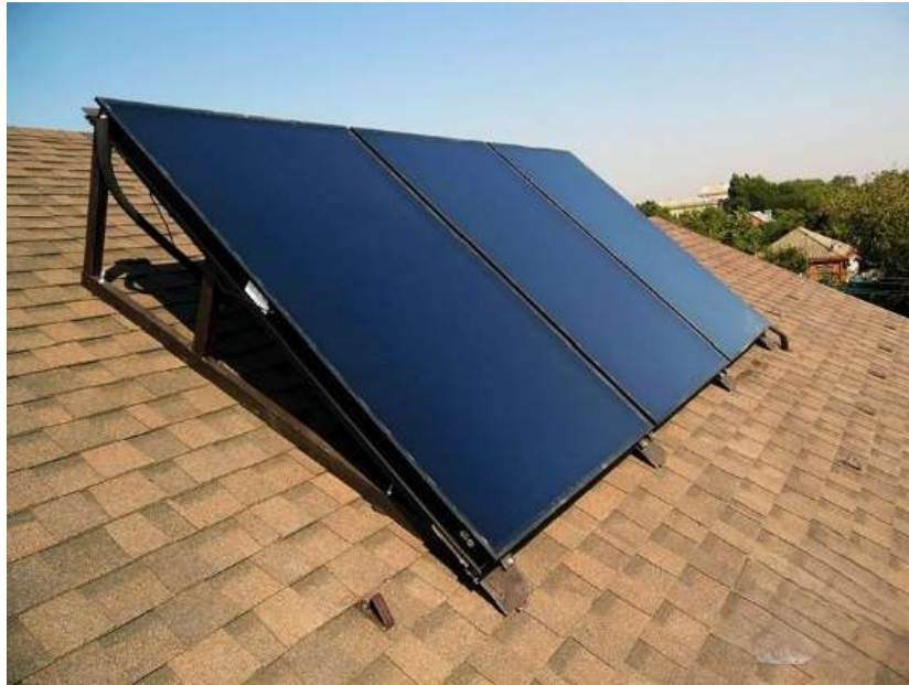
Рисунок 1.4 – Плоский сонячний колектор
