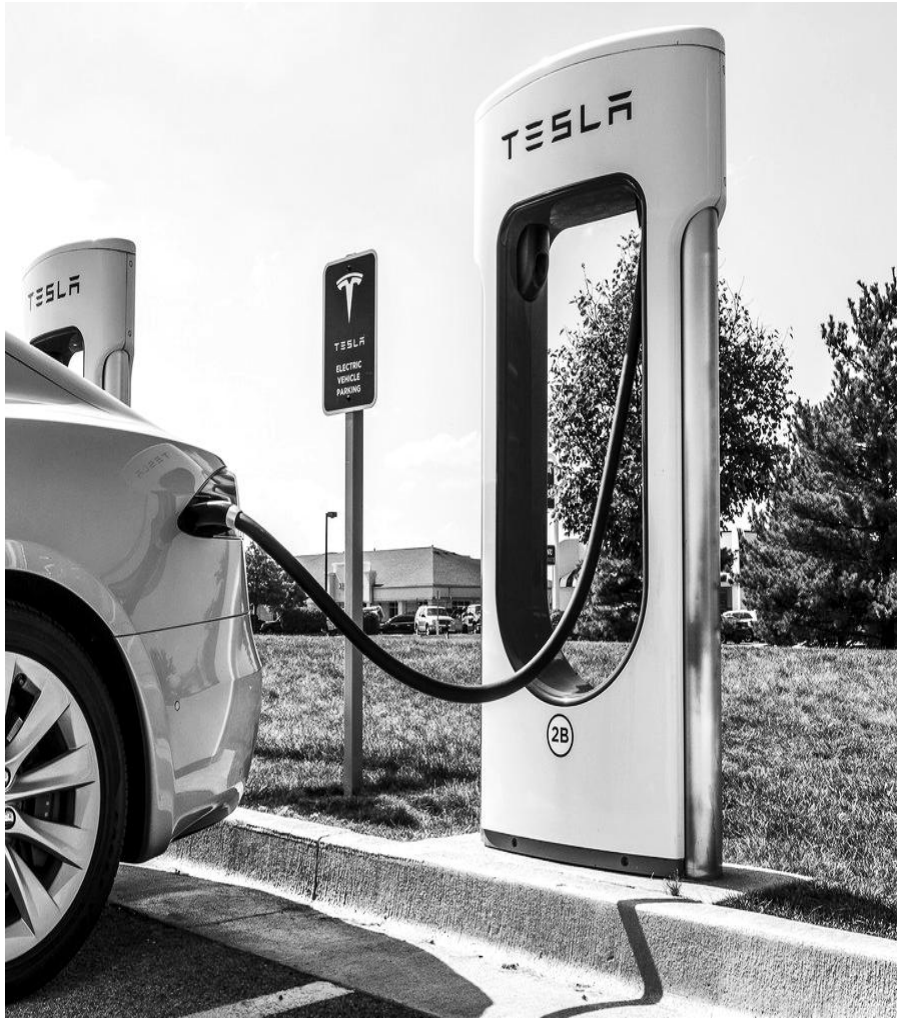
Рисунок 1.11 – Пункт заряджання електричного транспортного засобу за допомогою постійного струму великої енергетичної потужності
