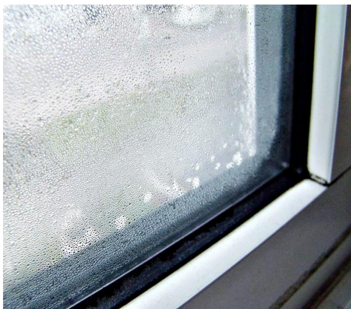
Рисунок 2.4 – Конденсація води на склопакеті
