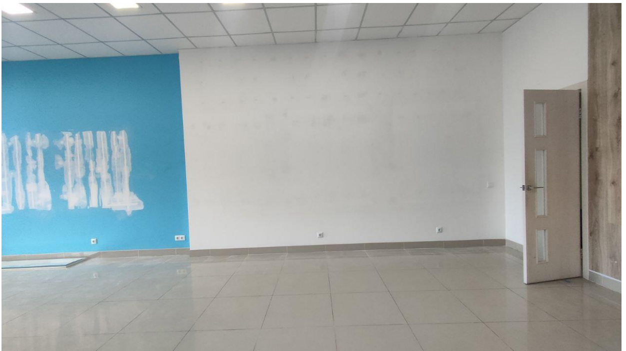
Рисунок А.4 – Фотографії приміщення
