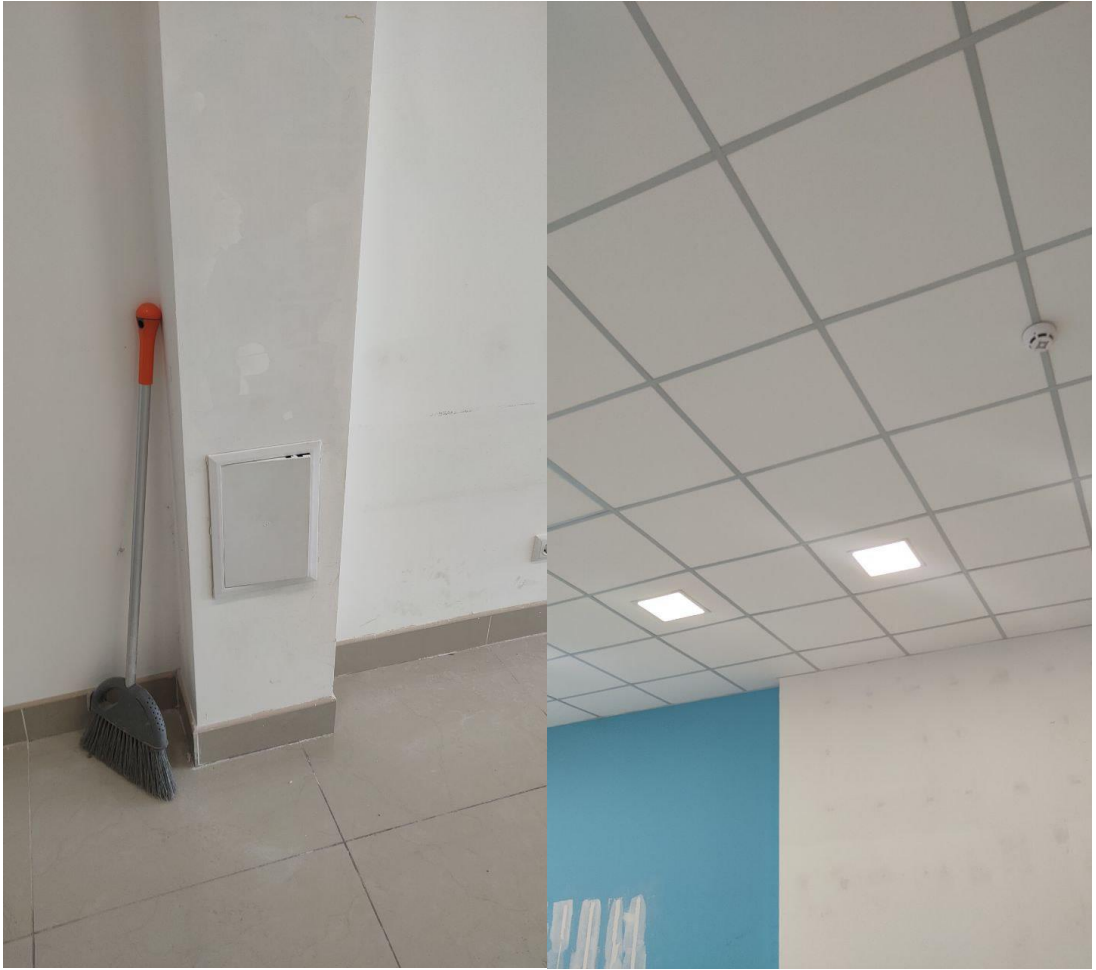
Рисунок А.3 – Фотографії приміщення
