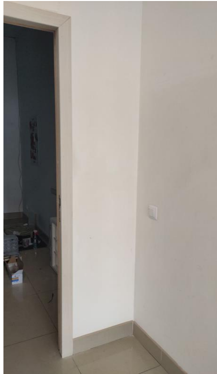
Рисунок А.1 – Фотографії приміщення
