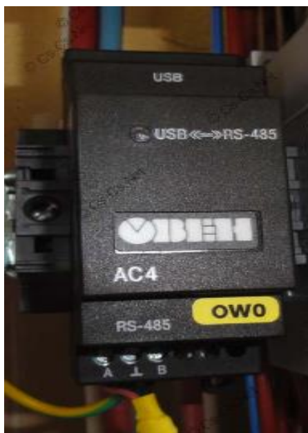
Рисунок 3.7 – Підключення AC4
