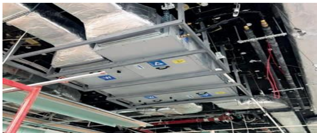
Рисунок 4.2.2 - Установки з пластинчастими рекуператорами[7]
