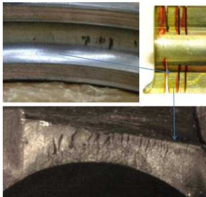
Рисунок 3.32 – Розташування та зовнішній вигляд розкритої тріщини (x30)
