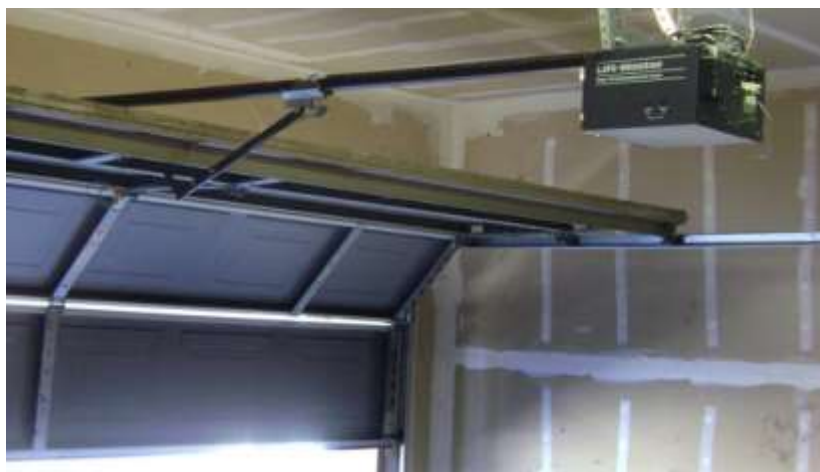
Рисунок 1.20 - Автоматика приводу секційних гаражних воріт
