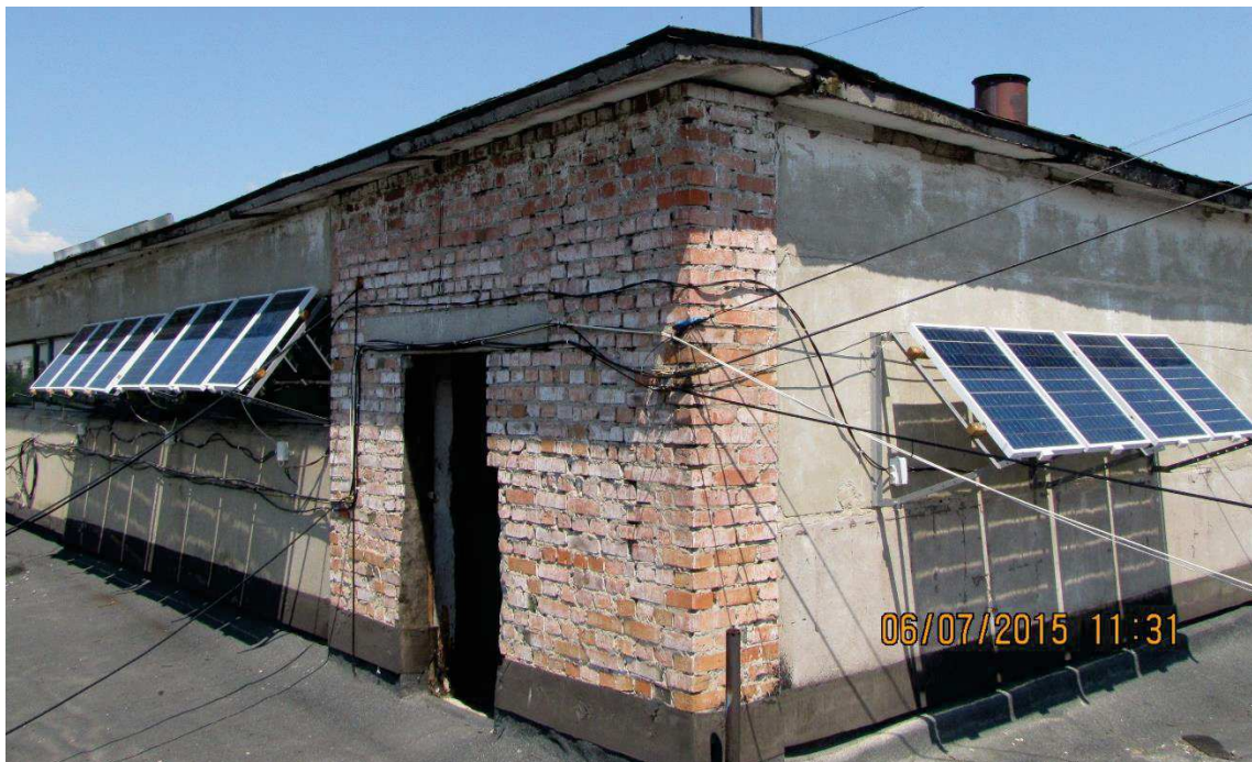
Рисунок 3.6 – Фото місця установки під поворотну систему сонячних панелей.
