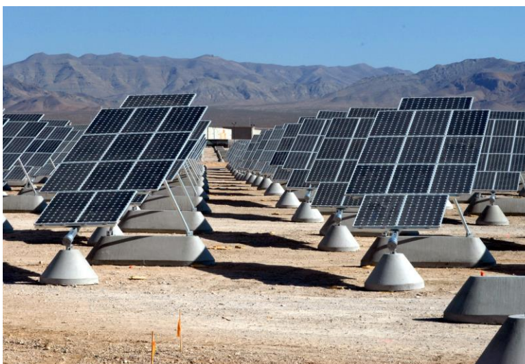
Рисунок 1.4 – Сонячна електростанція помірної кліматичної зони
