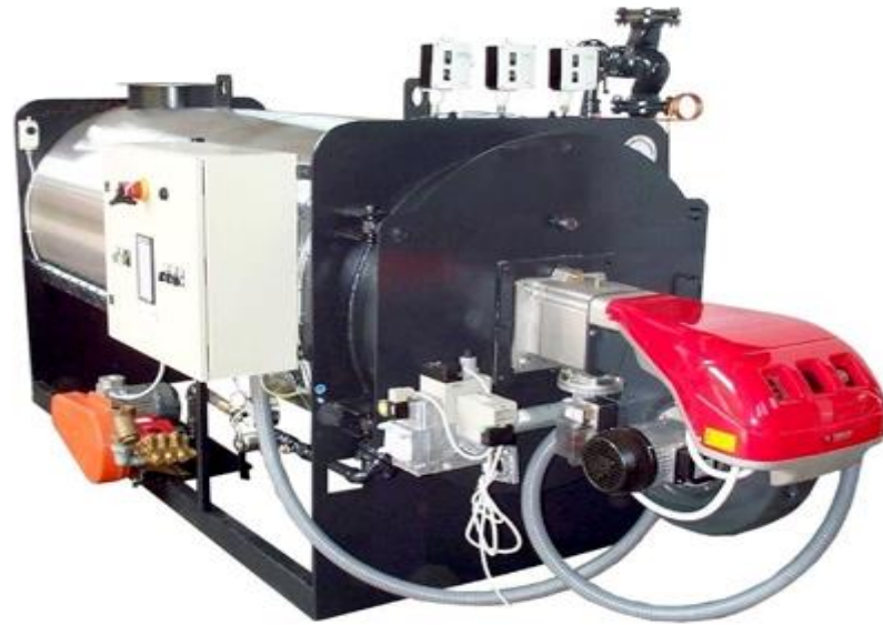
Рисунок 1.9 – Вид ВК – прямоочний котел
