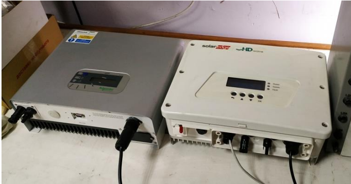
Рис. 3.36. Мережеві інвертори, які формують вихідну напругу \sim 230\text{В} , 50\text{Гц} .
