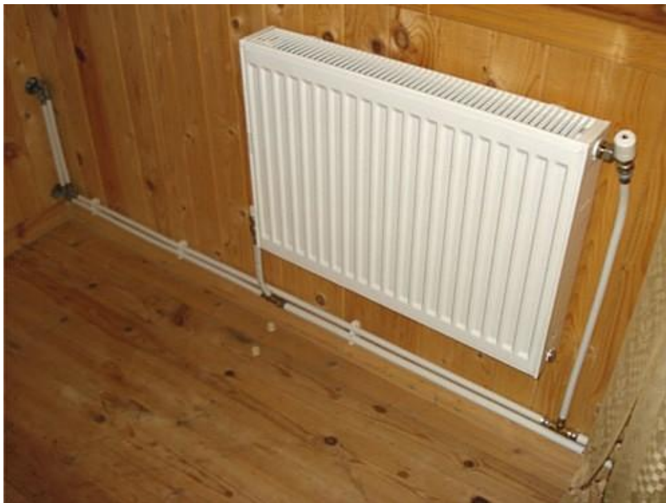
Рисунок 1.3 - Двотрубна схема з обов'язковим використанням дроселя для балансування
