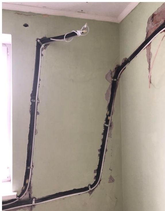
Рисунок 1.7 – Прокладання труб для циркуляції фреону в спліт-системах
