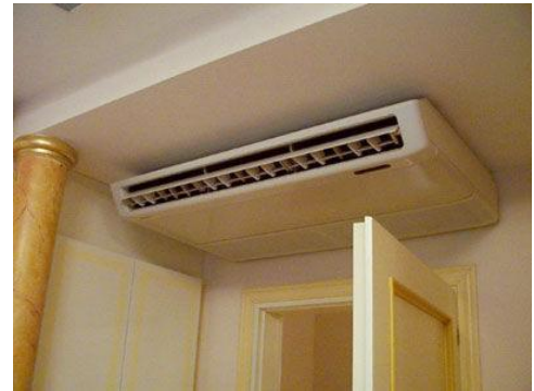
Рисунок 1.6 – Можливі кріплення внутрішніх блоків спліт-систем: а – касетні; б – настінні; в – колонні; г – підлогові; д - стельові
