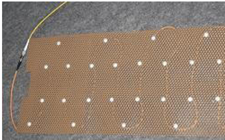
Рисунок 1.7 – Встановлення вібраційного сейсмічного кабелю на армуючій сітці горизонтального або вертикального розташування
