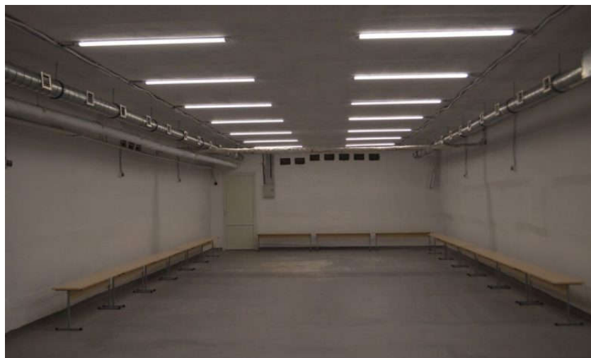
Рисунок 2.3 – Приклад укриття з правильною організацією освітлення
