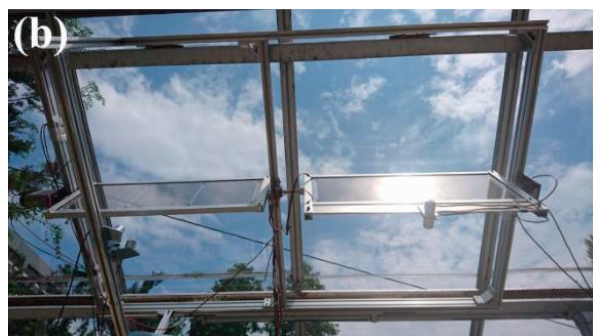
Рисунок 1.4 - Напівпрозорі фотоелектричні модулі, розташовані паралельно (А) або перпендикулярно (В) до поверхні даху [23]
