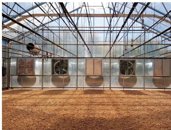
Рисунок 1.9 - Масиви вентиляторів динамічної системи вентиляції теплиці
