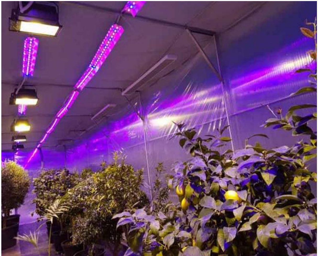
Рисунок 1.2 - Система штучного освітлення теплиці, яка використовує найефективніші довжини хвиль для фотосинтезу
