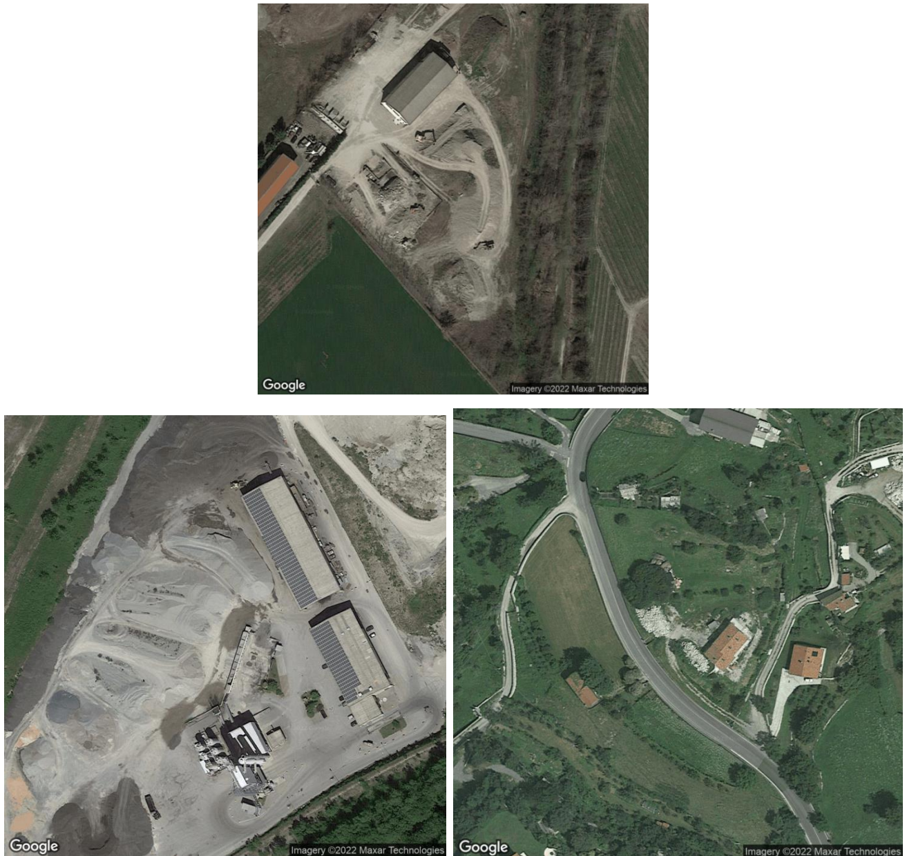
Рисунок 3.5 – Зображення будівельного сміття
