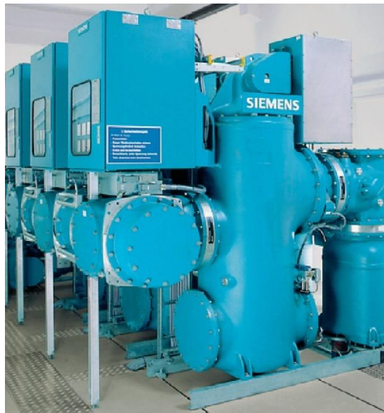
Рисунок 2.8 - Загальний вигляд КРПЕ типу 8DN8 фірми Siemens [26]
