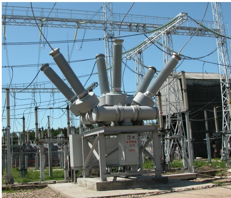
Рисунок 1.1 – Загальний вигляд високовольтного вимикача типу ВГБУ
