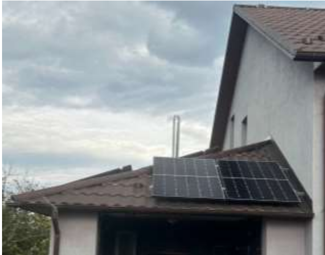
Рисунок 2.19 - Розміщення сонячних панелей стрінга 1 на гаражі
