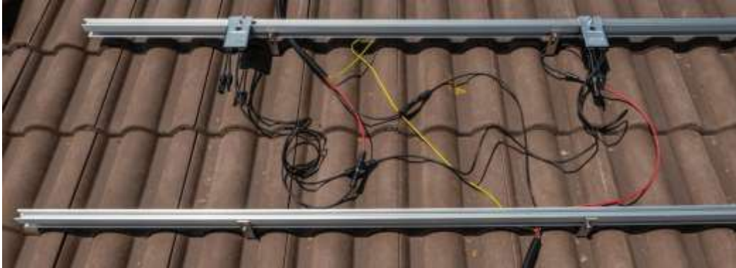
Рисунок 3.3 - Схем підключення оптимізатора
