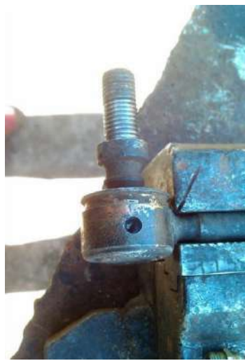
Рисунок 2.28 – Просвердлити бік шарніра.
