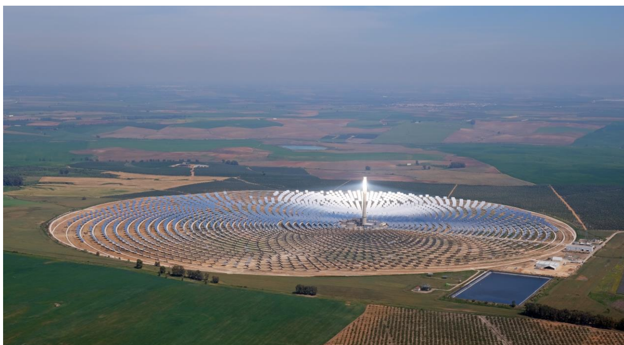
Рисунок 1.4 – Сонячна електростанція баштового типу
