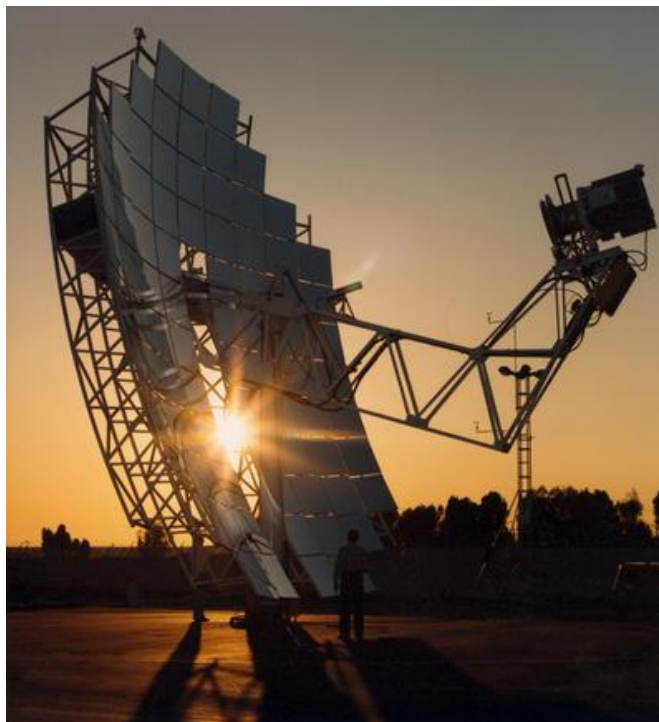
Рисунок 1.5 - Зовнішній вигляд системи сонячних тарілкоподібних рефлекторів
