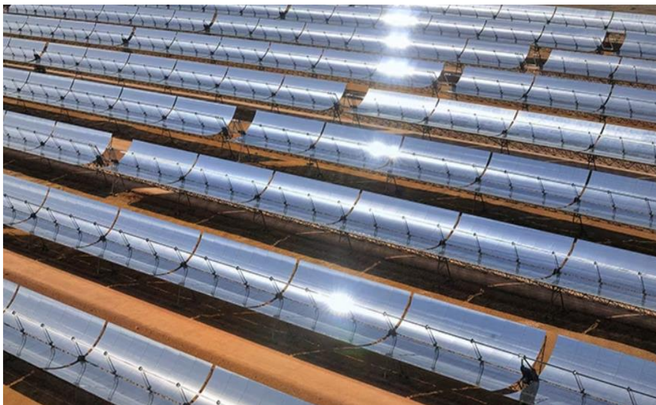
Рисунок 1.2 - Параболічний жолобовий колектор
