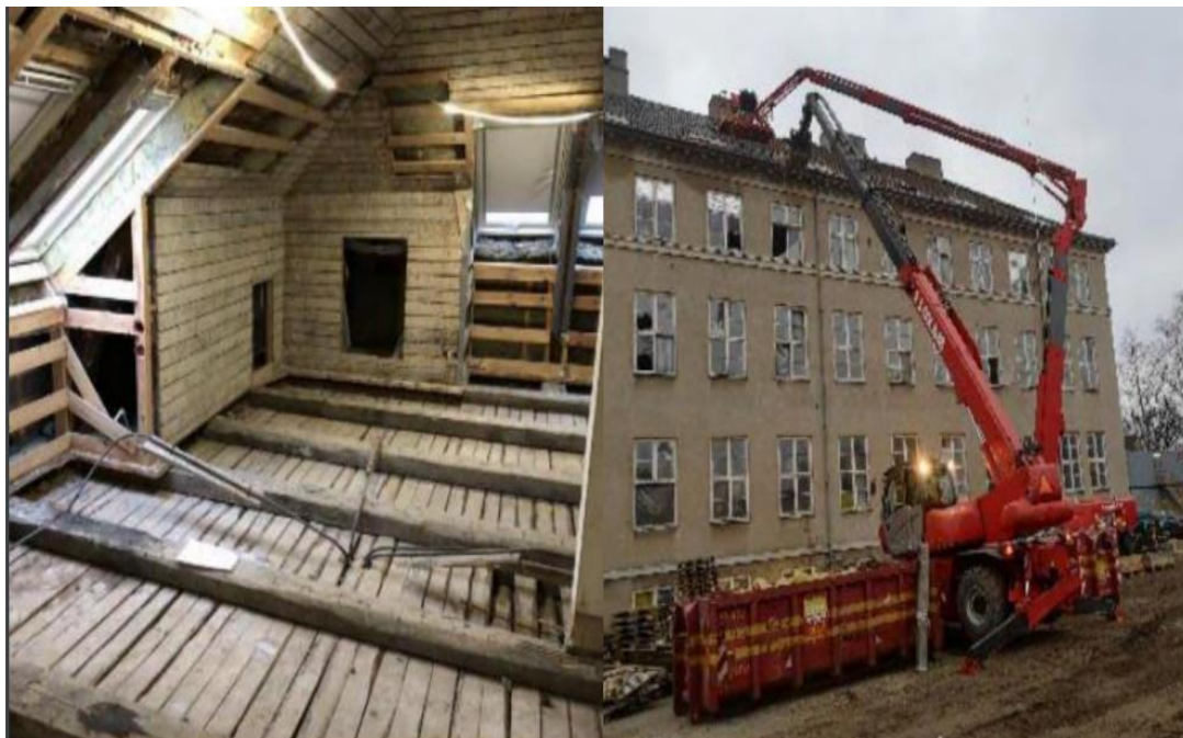
Рисунок 3.2 – Демонтаж черепиці для повторного використання
