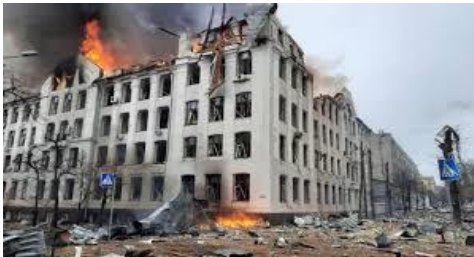
Рисунок 1.3 – Наслідки руйнації будівлі під час ракетного обстрілу (з мережі Internet)
