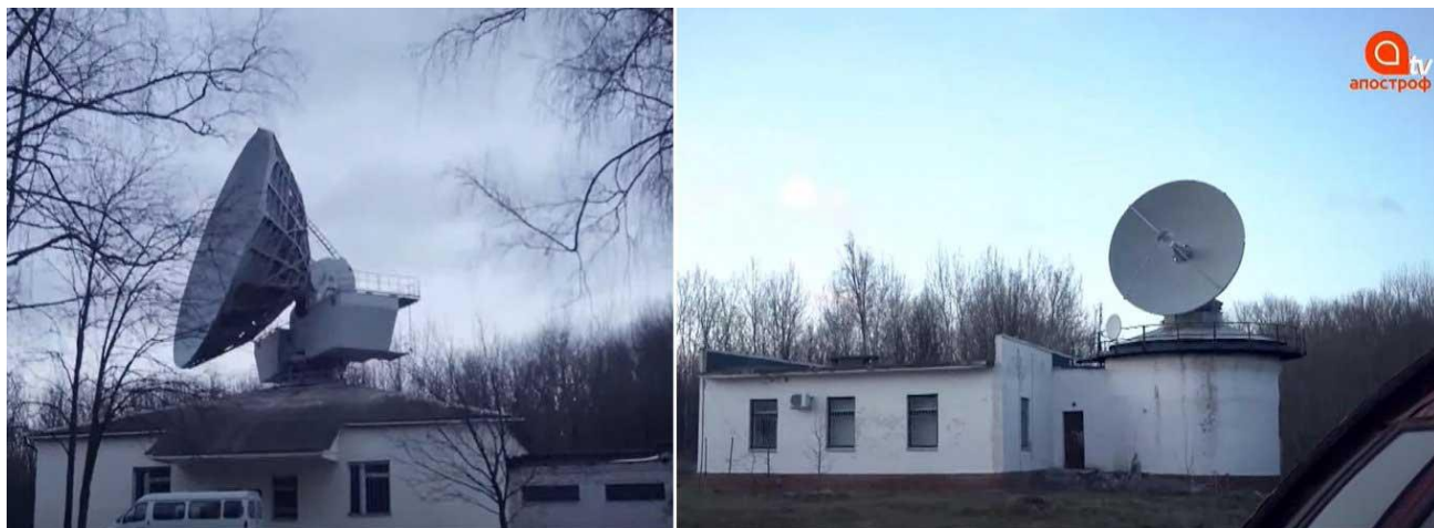
Рисунок 1.10 – Параболічні антени а) – діаметром 12 метрів; б) – діаметром 5 метрів центру управління супутників в Дунаївцях, Хмельницька область, Україна
