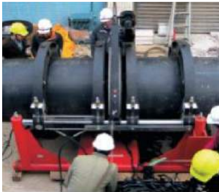
Рисунок 3.14 – Зварювання магістрального трубопроводу з полімерних труб за допомогою машини Roweld P1200
