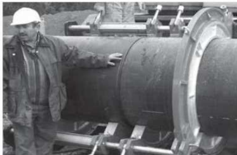
Рисунок 2.7 – Буртик при зварюванні поліетиленових труб
