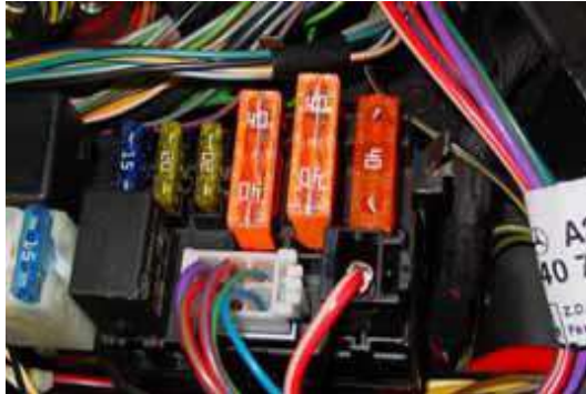
Рисунок 3.3 – Від'єднання запобіжника контролю рівня пневмопідвіски
