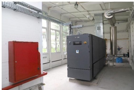
Рисунок 1.1 – Когенераційна установка Хмельницького національного університету Viessmann Vitobloc 200 потужністю 140 кВт
