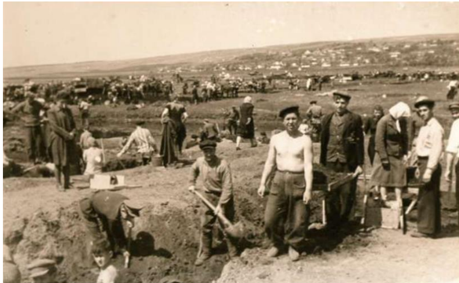
На будівництві водосховища, 1949-50 рр.
