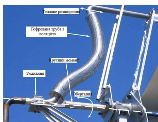
Рисунок 1.10 - Поворотний гнучкий шланг у зборі
