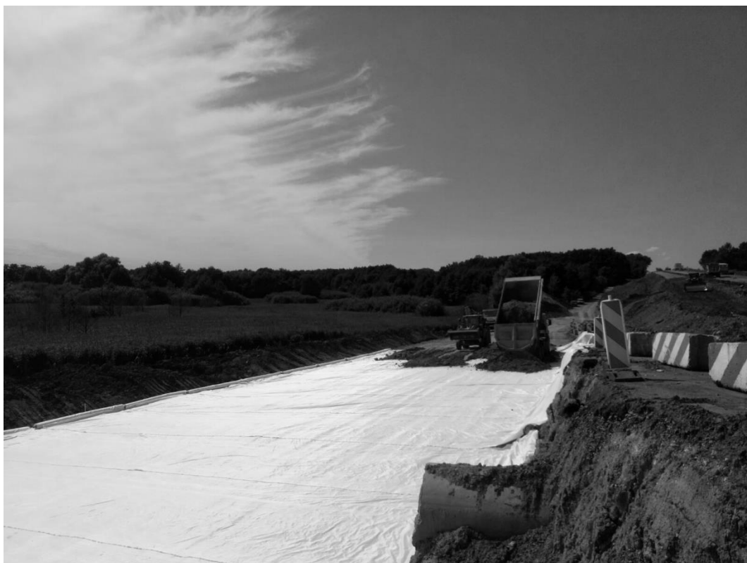
Рисунок 2.6 – Використання геосинтетичних матеріалів при облаштуванні основи дороги
