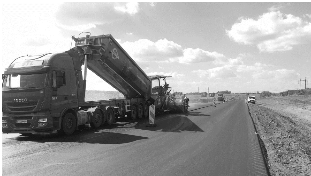
Рисунок 2.7 – Укладання ЩМА на автодорозі
