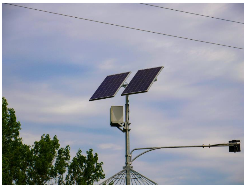
Рисунок 1.1 – Автономна системи електроживлення вуличного освітлення
