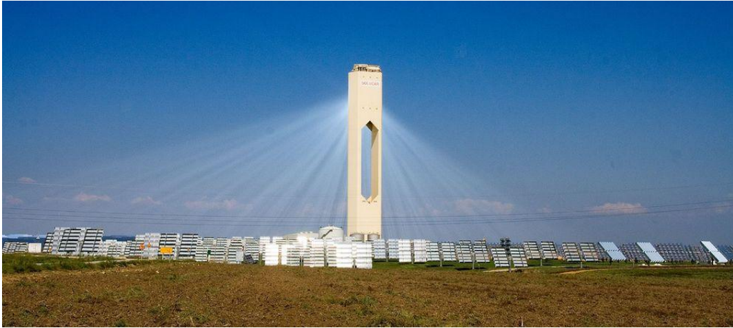
Рисунок 1.9 – Загальний вигляд концентратора баштового типу
