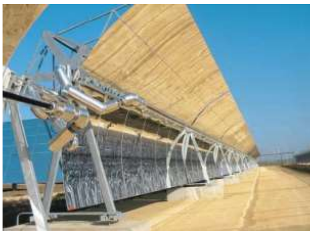
Рисунок 1.9 – Довгі параболічні (в поперечному перерізі) дзеркала «Solucar» з трубками для розігрівання теплового носія
