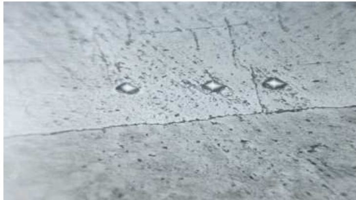
Рисунок 3.14 – Тріщини у покритті електролітичного заліза
