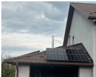
Рис. 2 Розміщення затієних сонячних панелей стрінга 1 на гаражі
