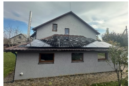
Рис.3 Розміщення сонячних панелей стрінга 2 на гаражі
