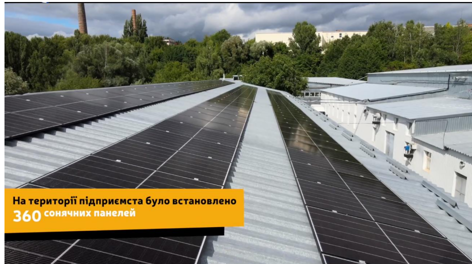
Рисунок 2.4 – Сонячна електростанція підприємства
