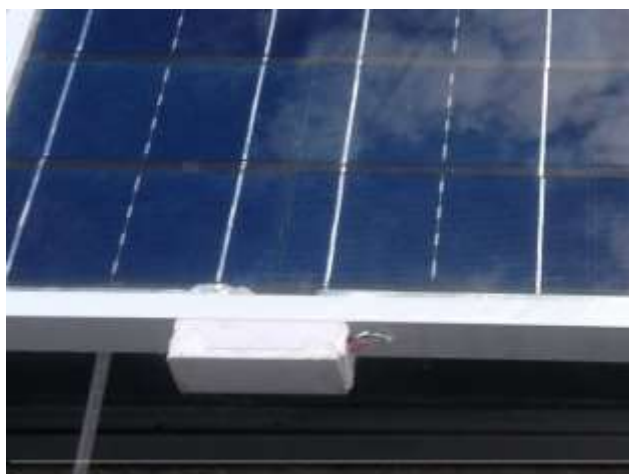
Рисунок 3.21 - Розташування захисної коробки
