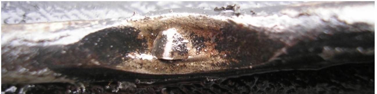
Рис. А.6. Фотографія поверхні металевого трубопроводу гальмівного механізму задніх правих коліс після силового та корозійного впливу
