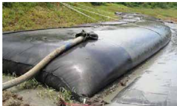
Рис. 8. Фотофіксація геотуб у прибережній зоні ставка Горащиха, де здійснювали зневоднення та висушування суміші земляних та мулових мас
