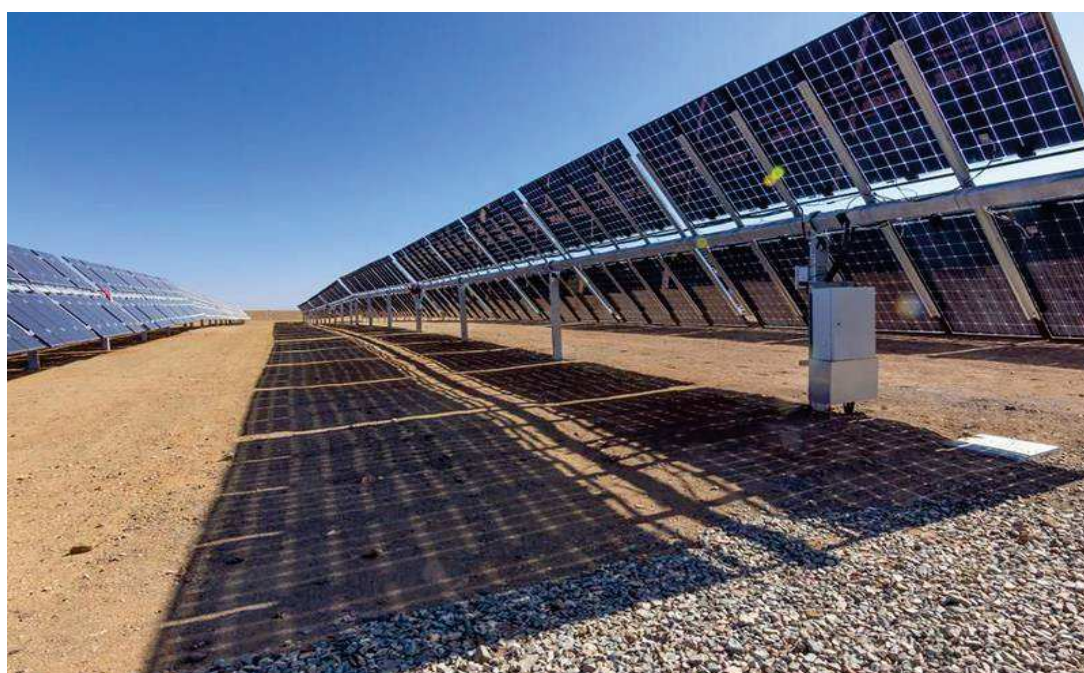
Рисунок 1.12 – Двосторонні (біфіціальні) сонячні панелі [24]
