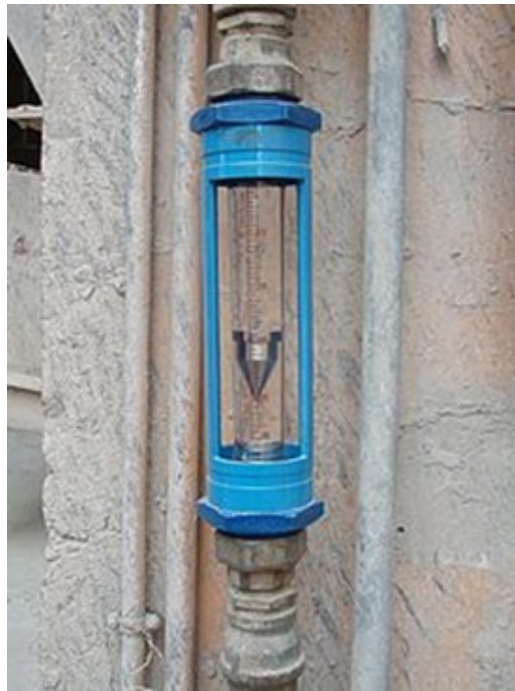
Рисунок 1.5 - Ротаметр Techfluid-CG34-2500
