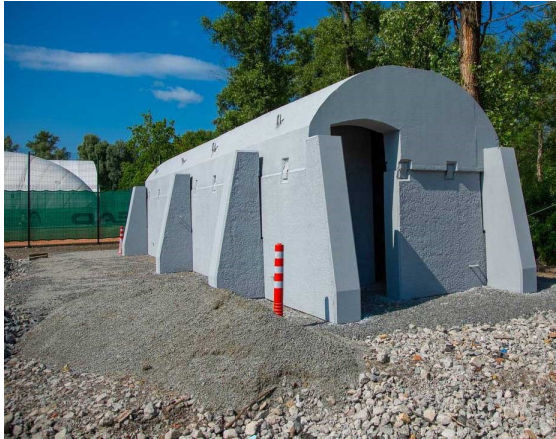
Рис. 1. Швидкоспоруджувальна захисна споруда модульного типу (ШЗСМТ)
