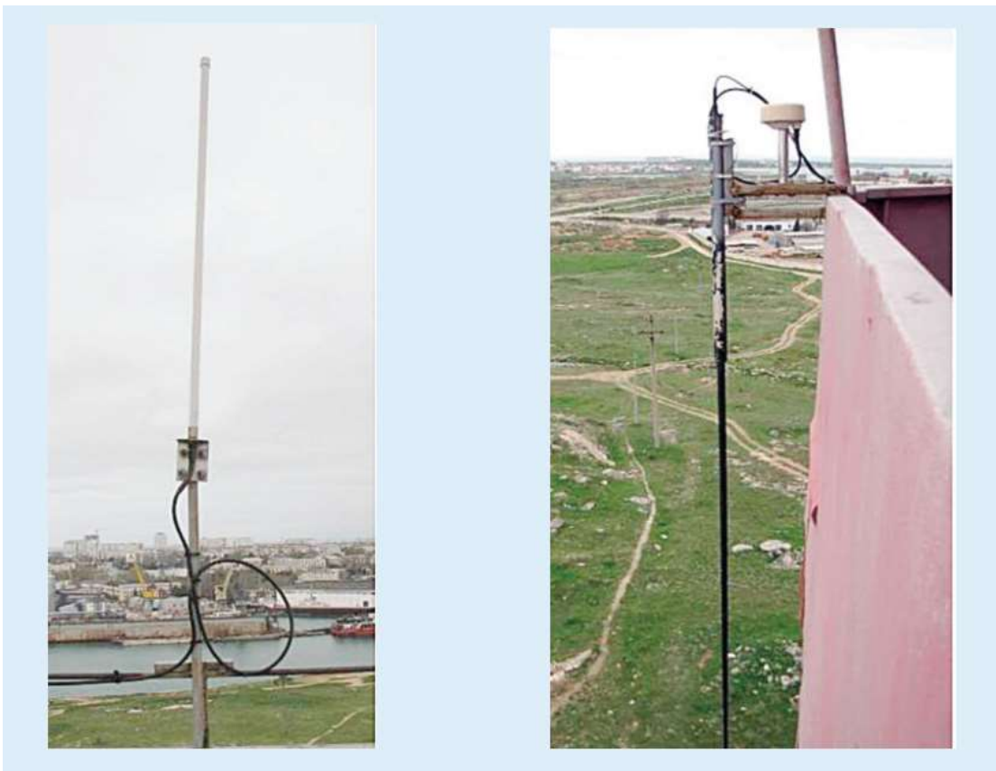
Рисунок 2.1 – Апаратні складові АІС (УКХ-передавач та УКХ-приймач, приймач GPS)
