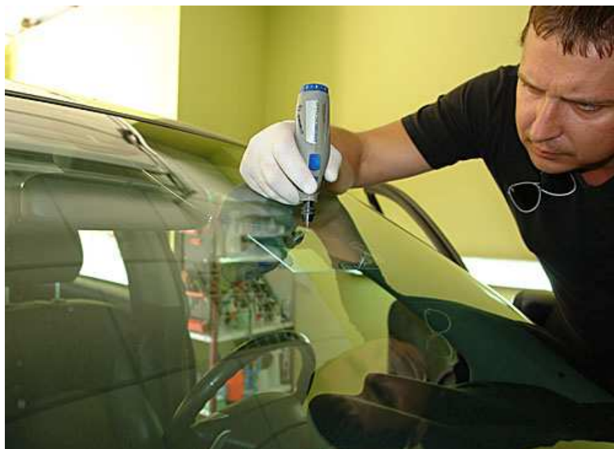
Рисунок 2.8 – Засвердлювання тріщини
