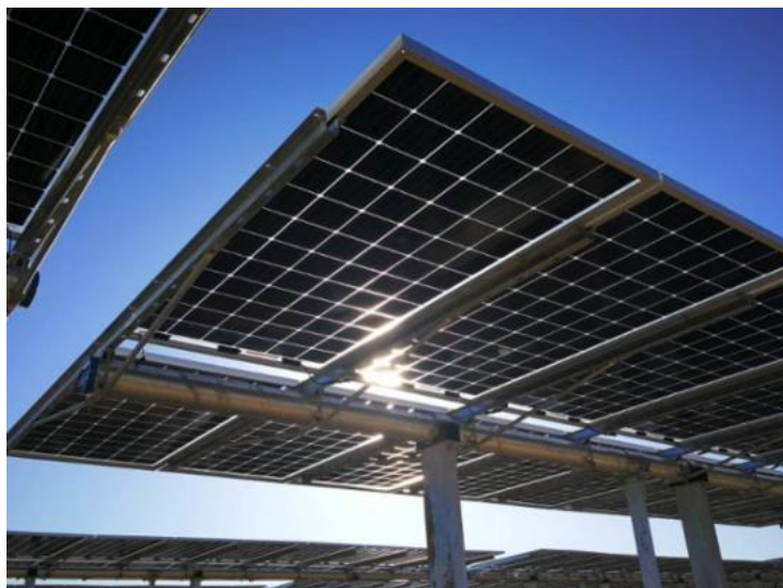
Рисунок 1.12 - Двосторонні (bifacial) сонячні панелі [92]
